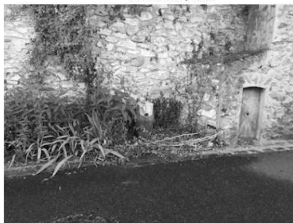
Photo de l'hydrant
