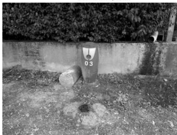
Photo de l'hydrant
