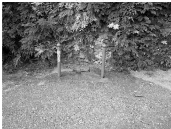
Photo de l'hydrant
