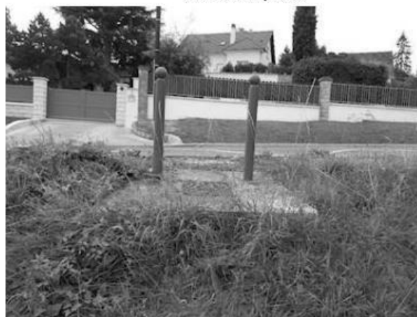
Photo de l'hydrant
