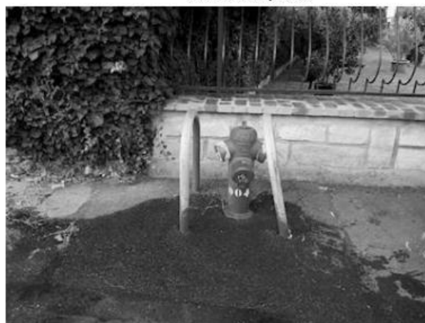
Photo de l'hydrant
