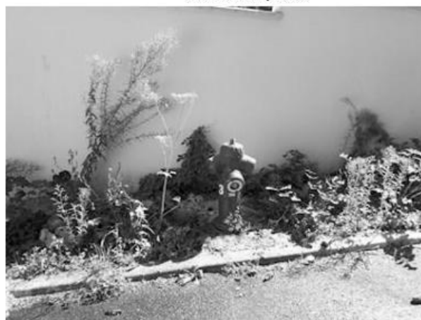
Photo de l'hydrant
