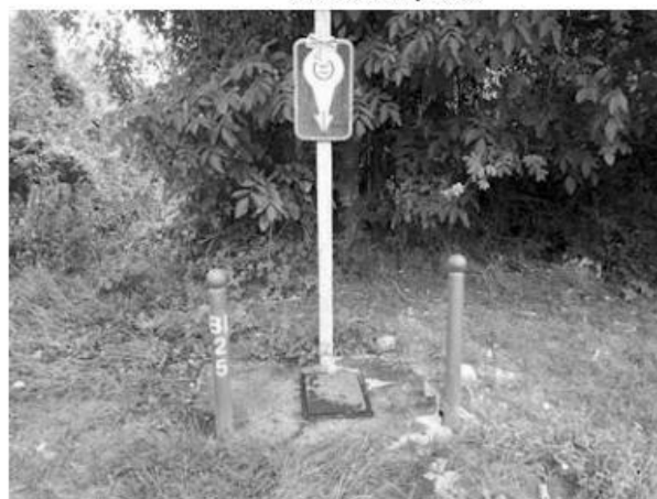
Photo de l'hydrant
