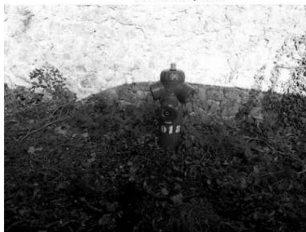
Photo de l'hydrant
